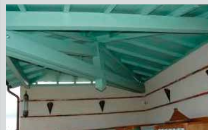
Dachkonstruktion lackiert mit BLENDA-CRYL WV-290
