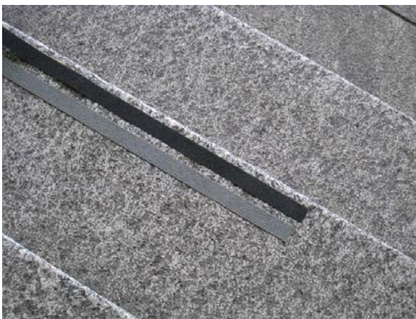
Abbildung 27 Antirutsch-Bänder machen auf Treppenkanten aufmerksam
