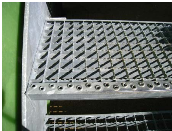
Abbildung 24 Sägezahnartige Ausbildung eines Rostes
