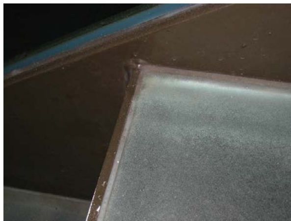
Abbildung 13 Kanten von Einfassungen müssen aufgeraut sein
